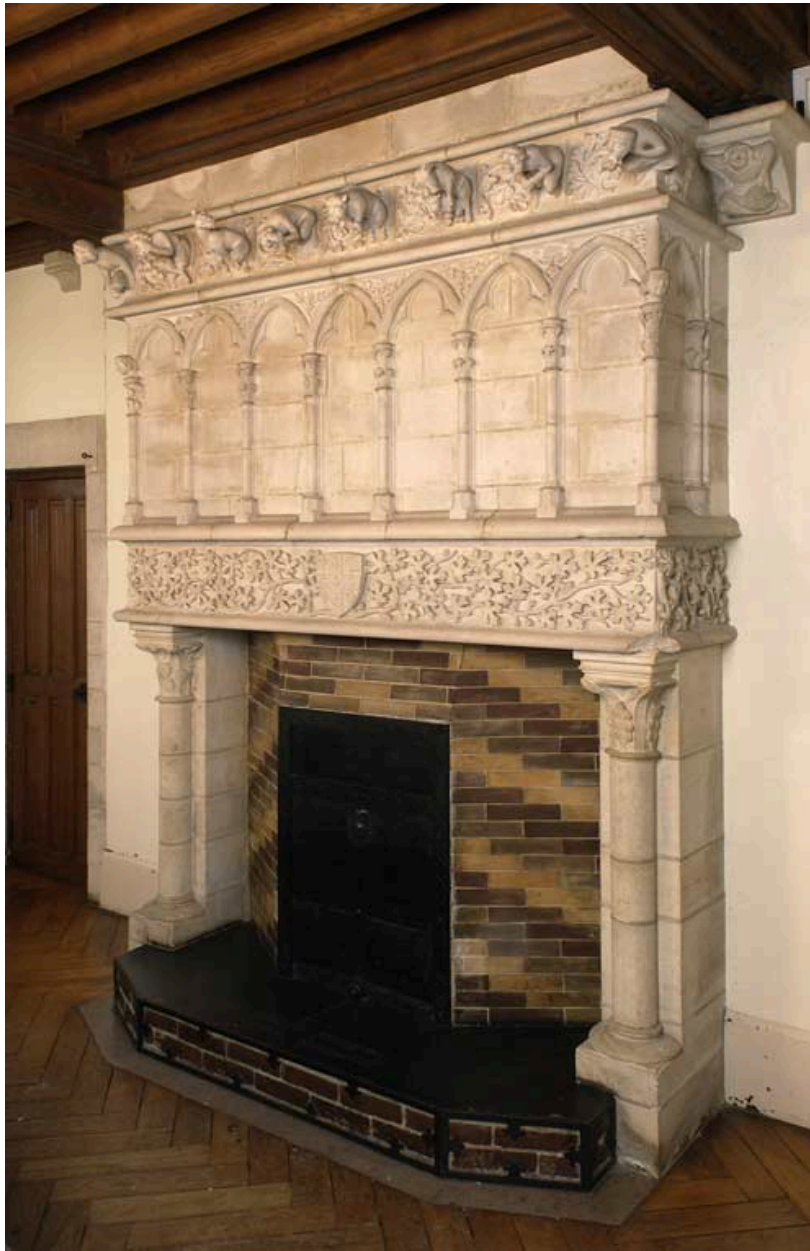
Bâtiment du réfectoire : partie sud du bâtiment (aménagement néo-gothique) : salle dite des moines (au rez-de-chaussée), cheminée.
