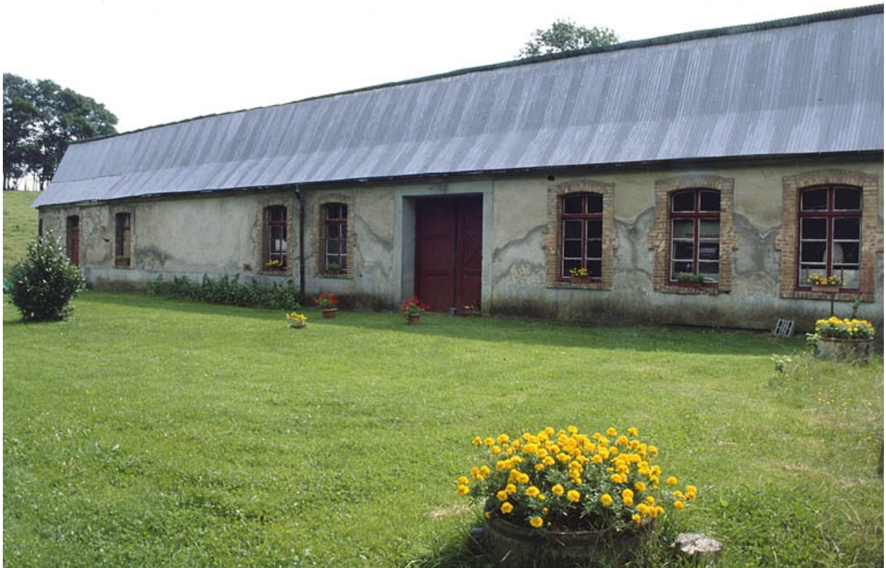
Façade (remaniée) de l'atelier de fabrication.
