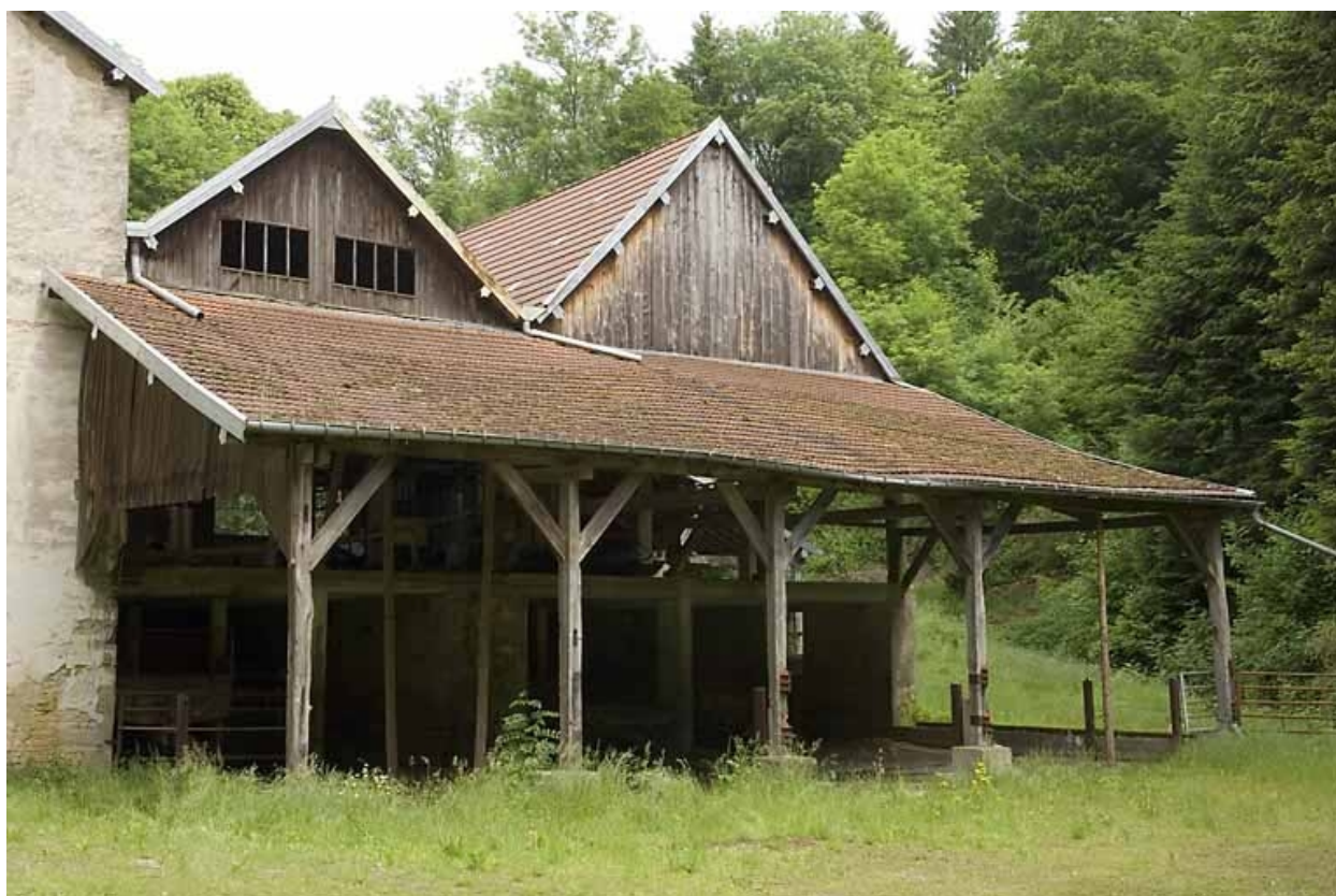
Façade et appentis sud.
