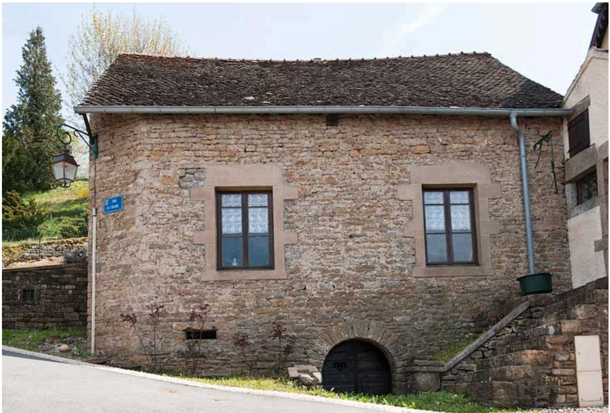
Grange : façade antérieure.
