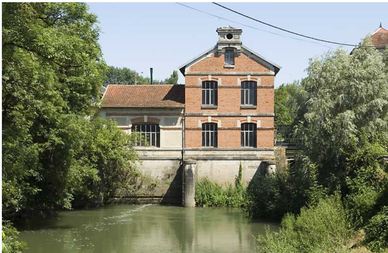
Vue rapprochée du bâtiment d'eau.
