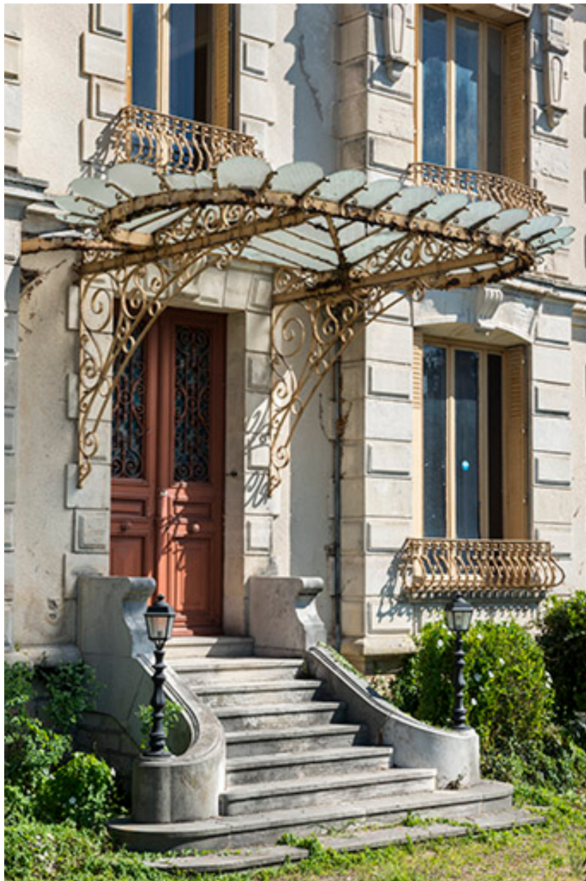
Porte d'entrée principale surmontée d'une marquise, vue de trois-quarts.
