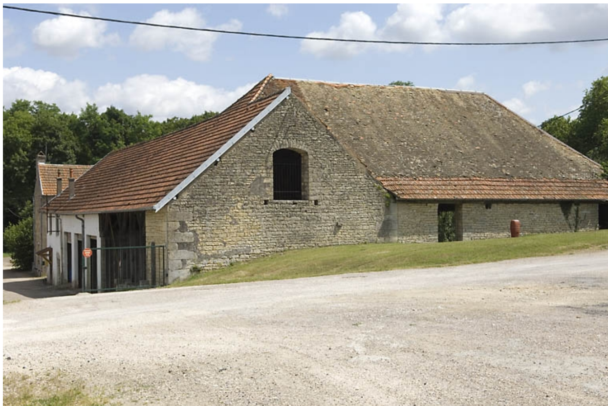
Halle à charbon depuis le sud-est.
