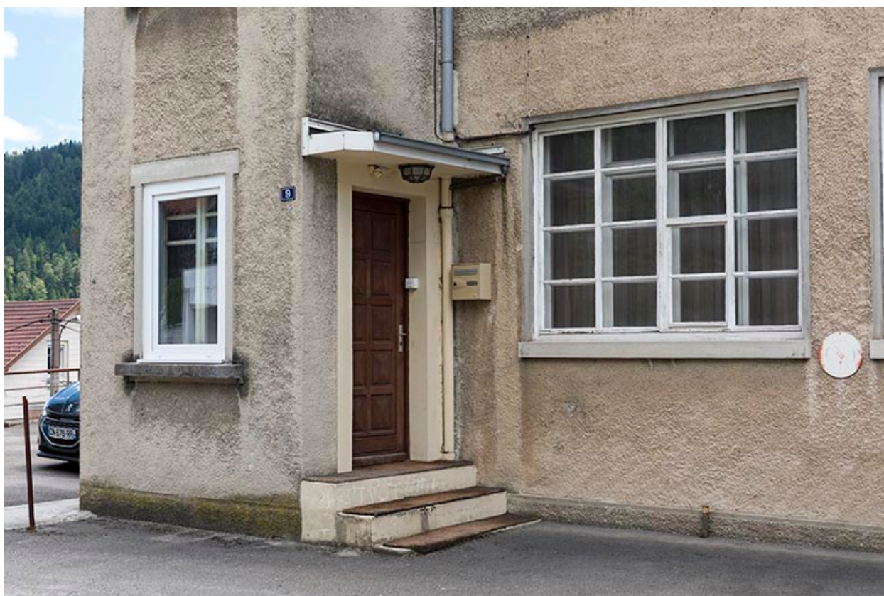
Façade nord : entrée rue Pasteur.
