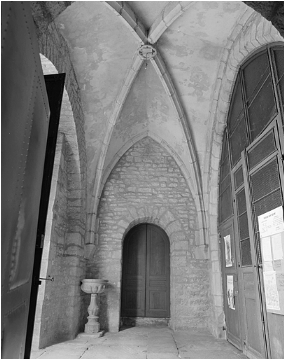
Eglise Saint-Désiré. Vue d'ensemble du vestibule d'accès nord.
