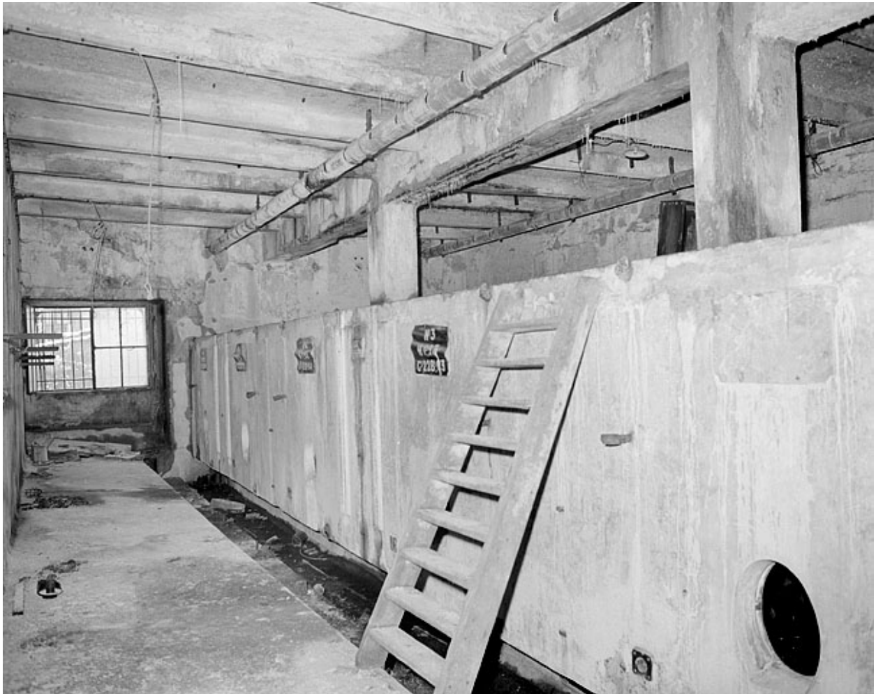
Premier étage, salle des cuves.
