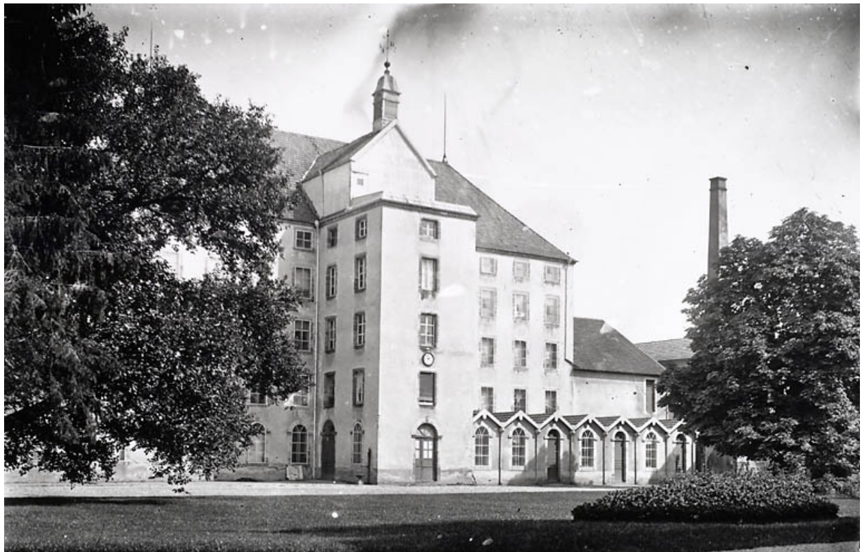
Elévation ouest de l'ancienne filature.
