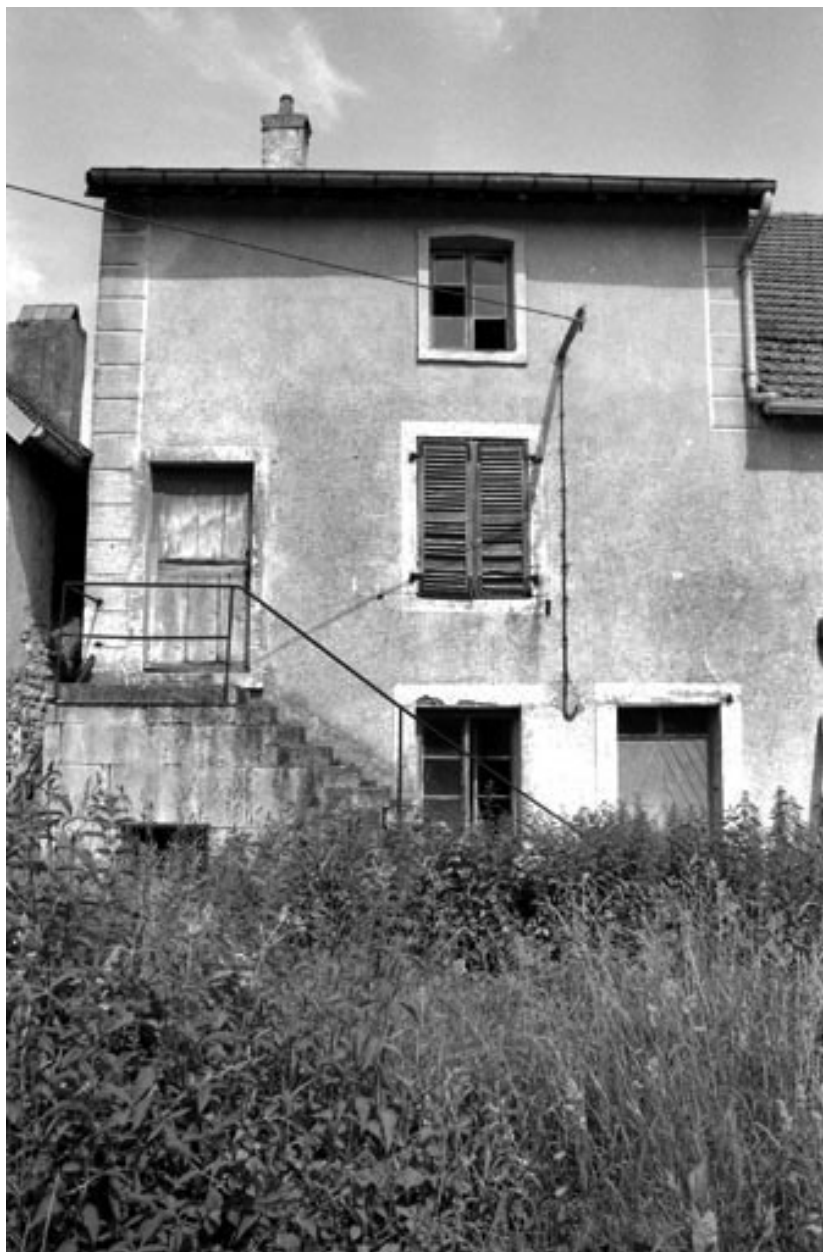
Vadans, ferme située rue Gazelle : exemple de ferme avec cave sous l'escalier extérieur.
