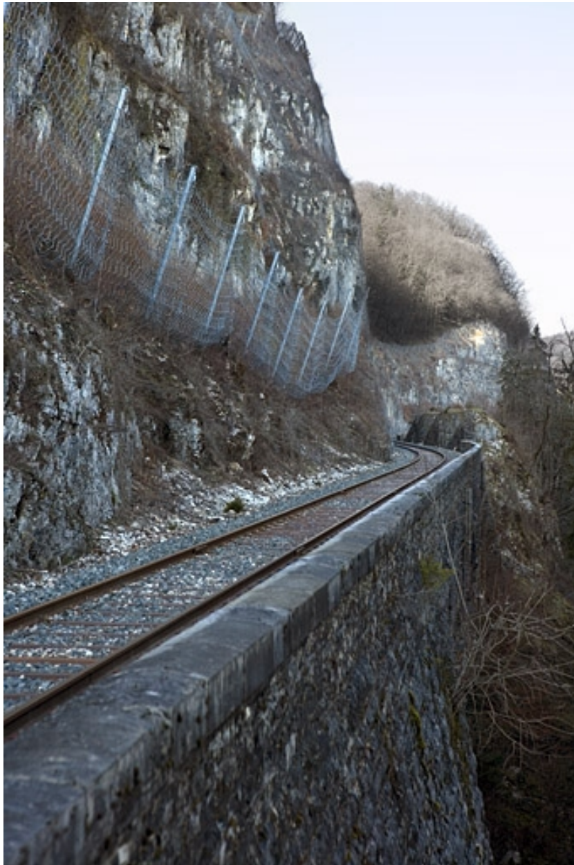
Mur de soutènement vers la vallée, depuis le côté La Cluse.
