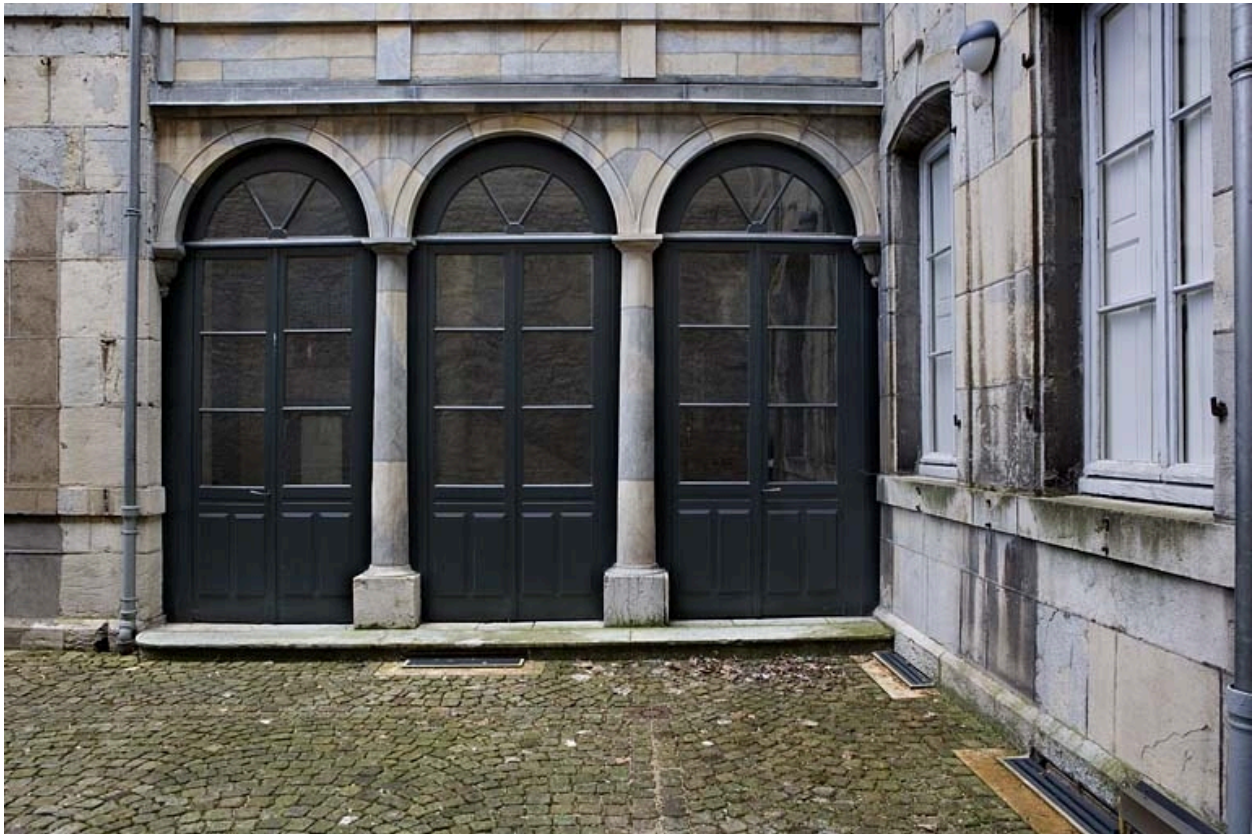
Vue extérieure de l'aile de l'escalier, de face.
