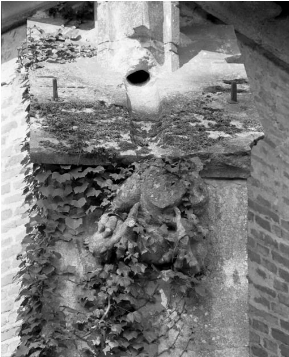
Gargouille (?) sur le contrefort gauche de la chapelle gauche.
