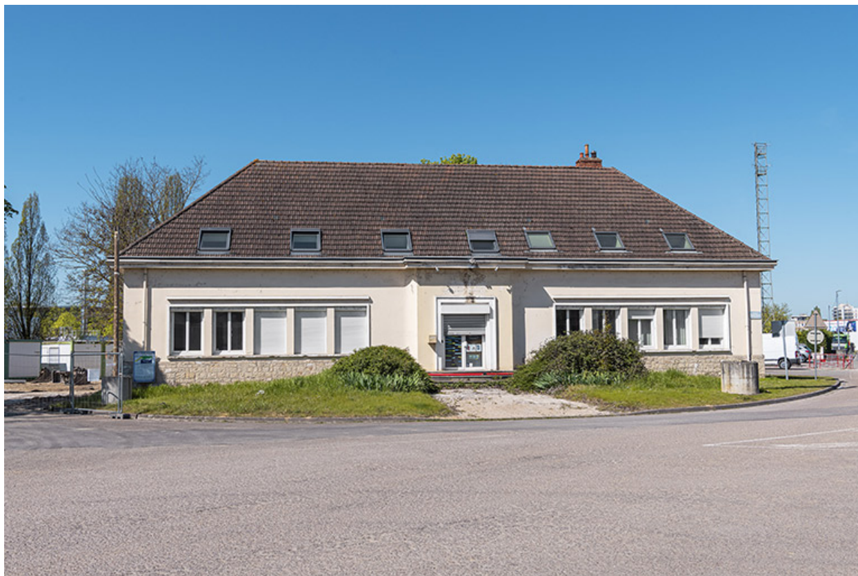
Bureau du port (VNF) : façade principale.
