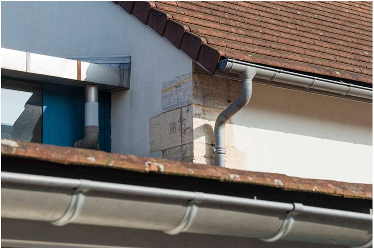
Détail de toitures de l'ouest des ateliers avec date portée : 1875.
