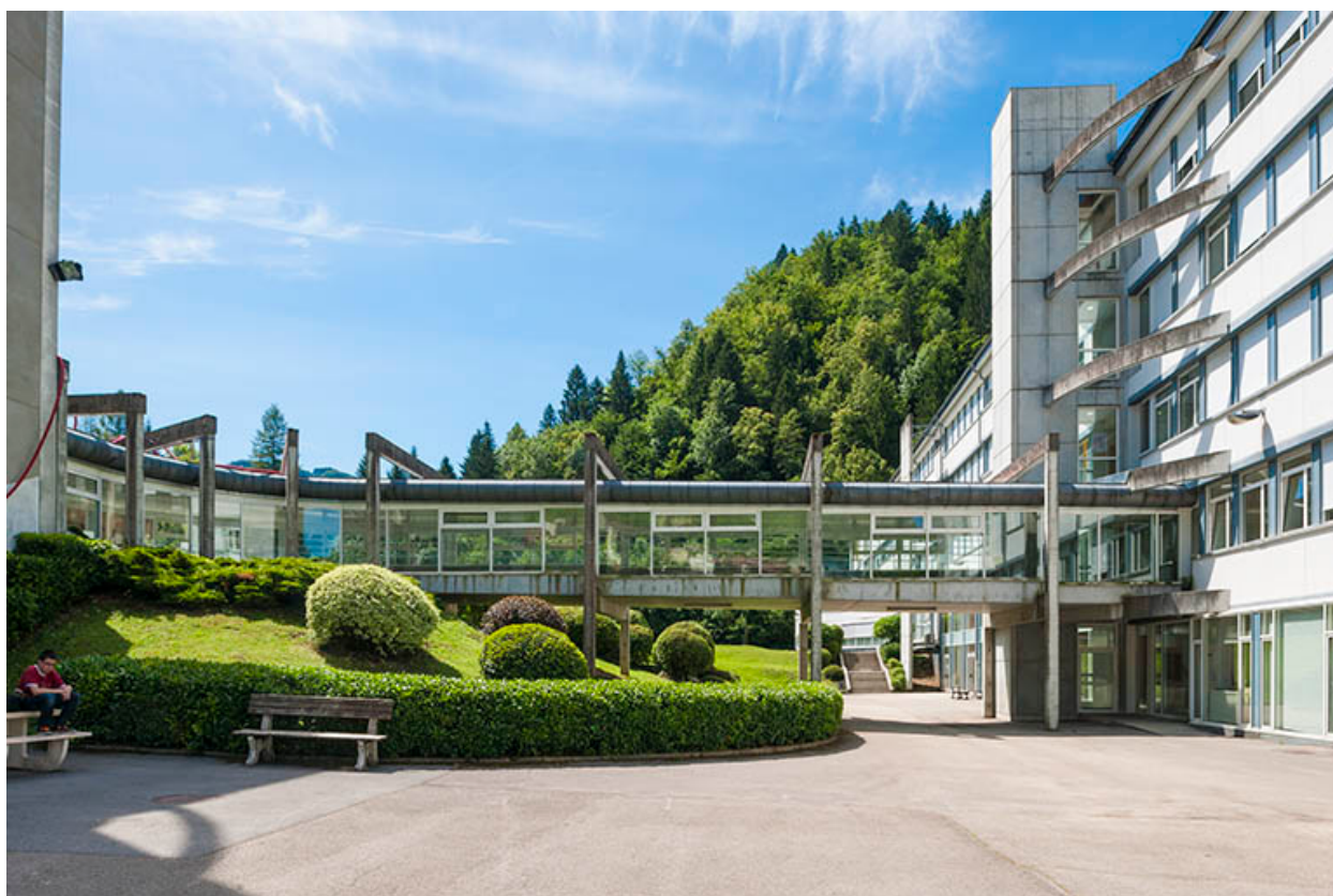
Passerelle couverte entre internat et externat.
