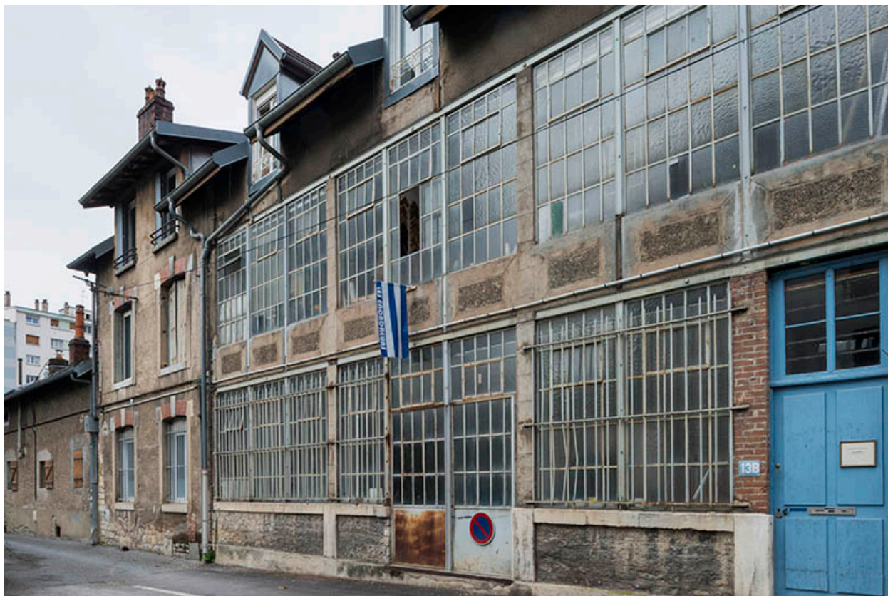
Façades d'ateliers ruelle de la Mouillère.
