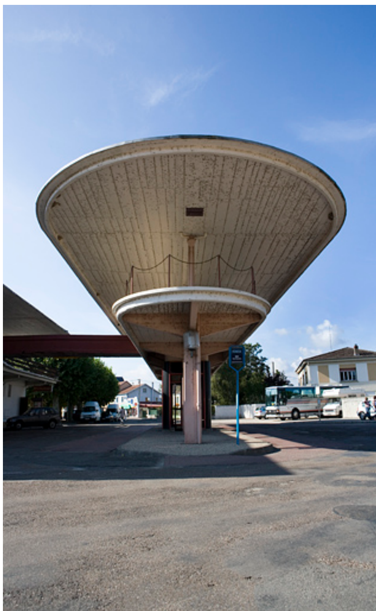
Station bus avec auvents.
