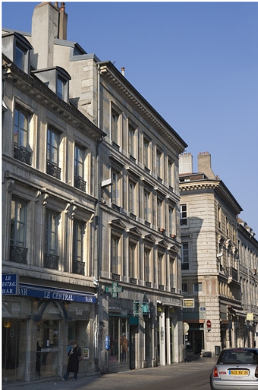
Vue d'ensemble de l'immeuble depuis la rue des Granges, de trois quarts gauche.
