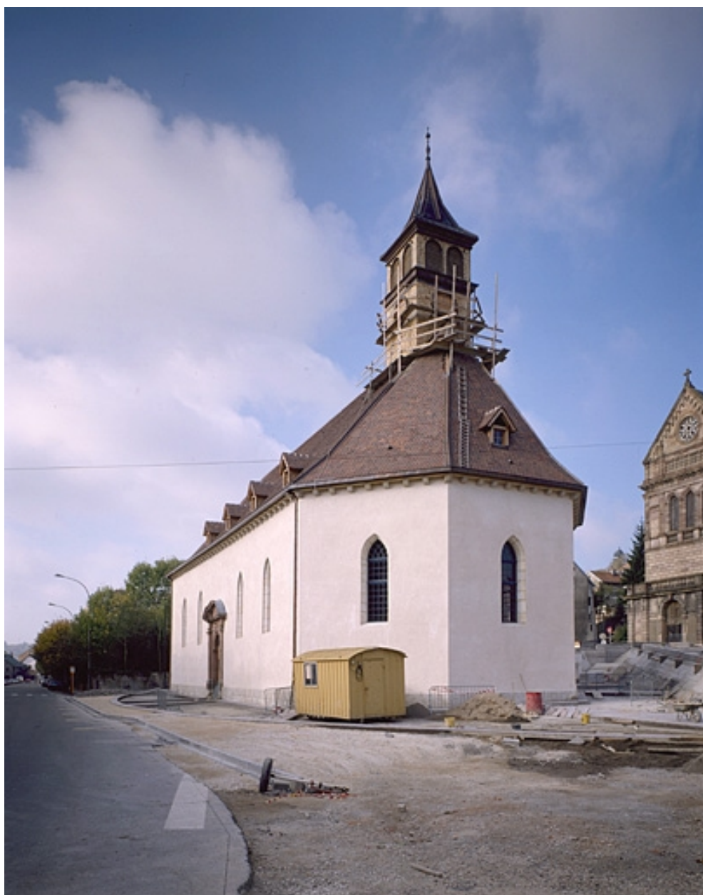
Vue d'ensemble des faces est et sud.
