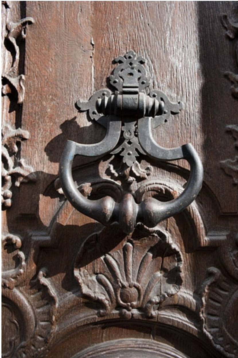
Façade antérieure sur rue, portail d'entrée : détail du heurtor.
