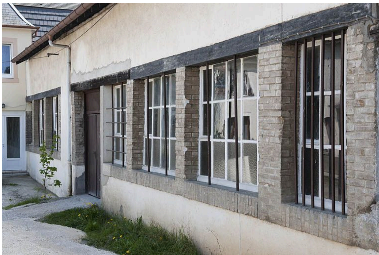
Mur nord de l'atelier de fabrication.
