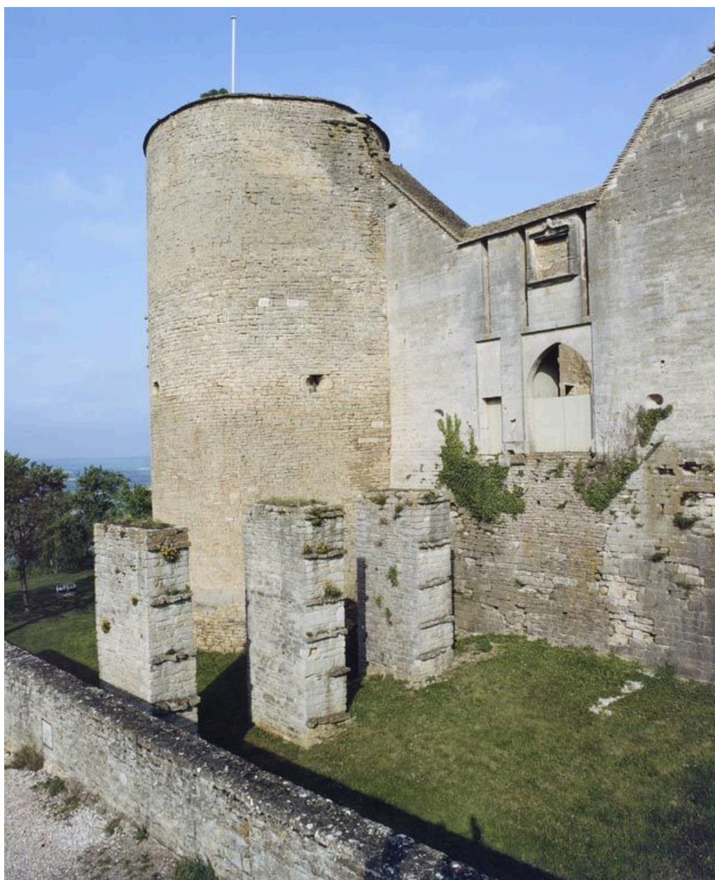
Elévation sud-est et tour sud.
