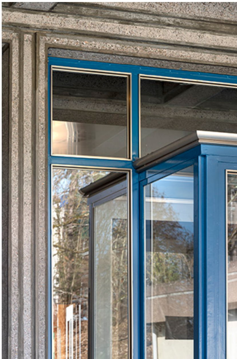
Façade antérieure, corps central : détail de l'entrée.
