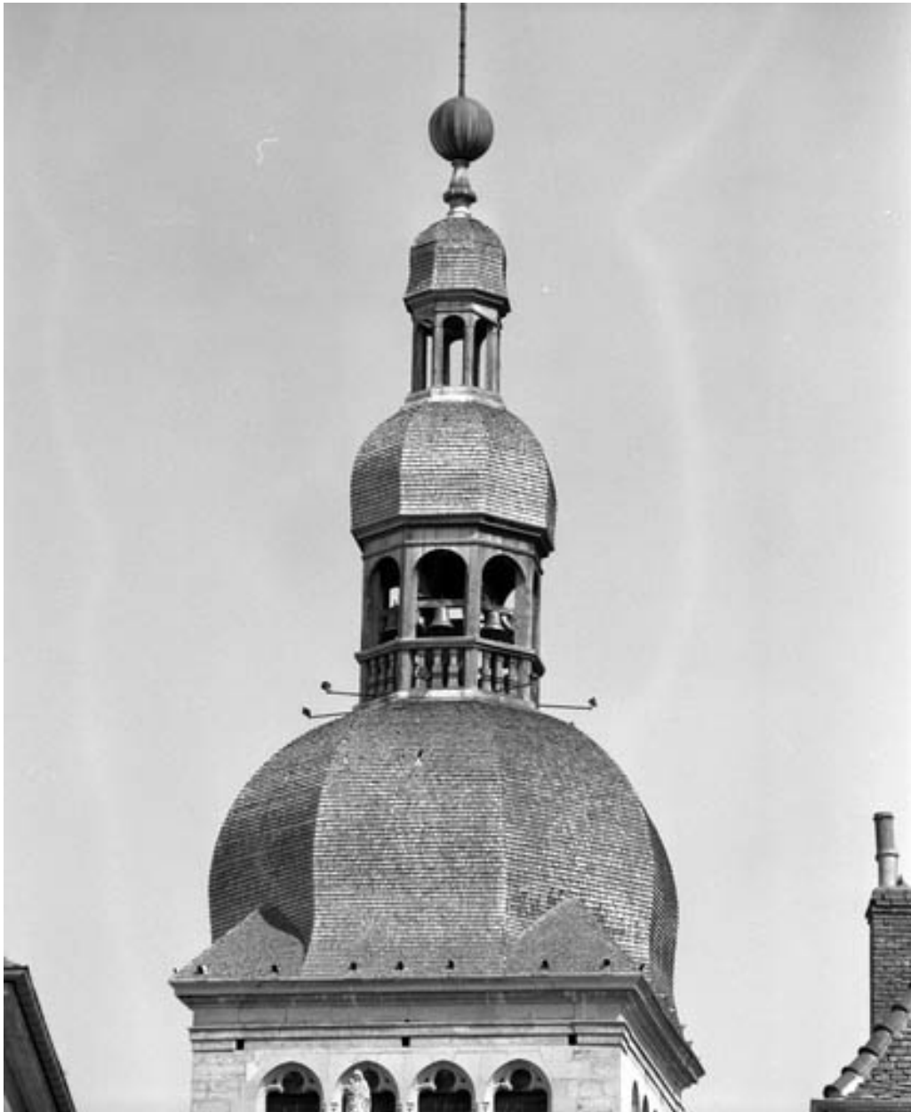
Tour-clocher : détail du bulbe et du lanternon.
