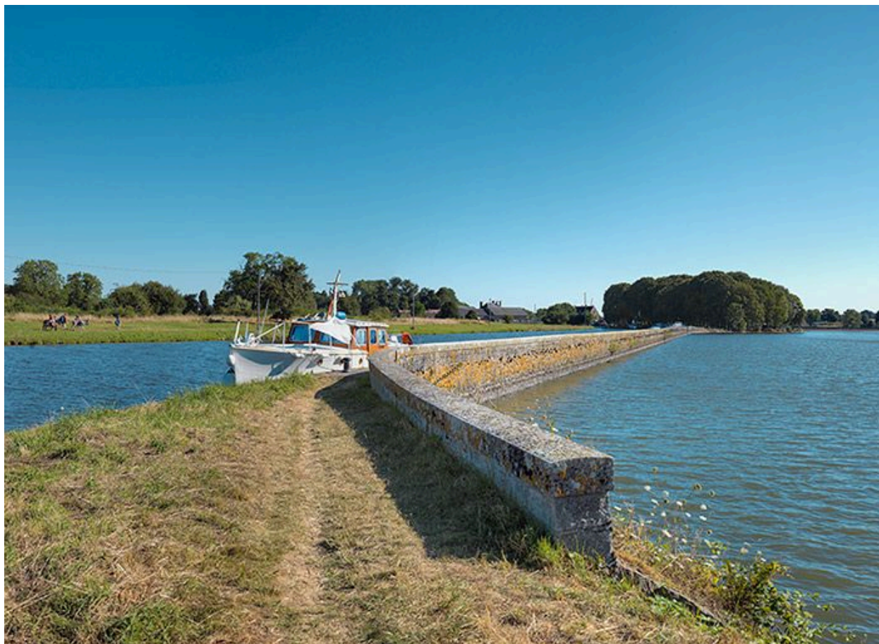
Vue de la digue séparant le canal et l'étang de Baye.
