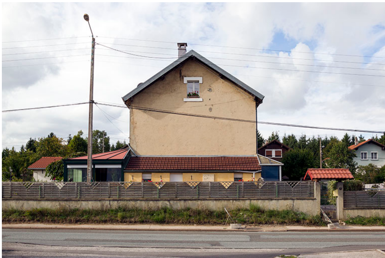
Immeuble au n° 9 : façade latérale sud.
