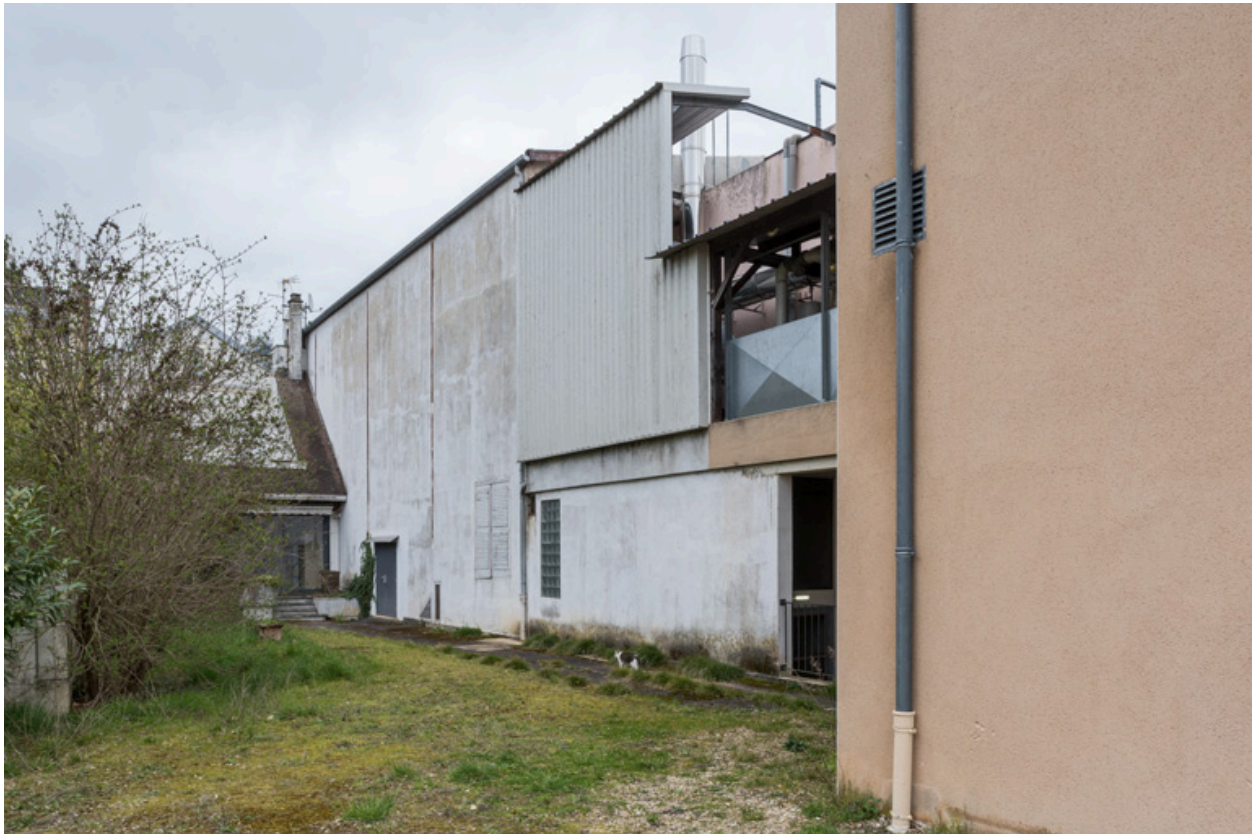
Salles 1-2 (ancienne salle de spectacle) et 7, vues de l'ouest.
