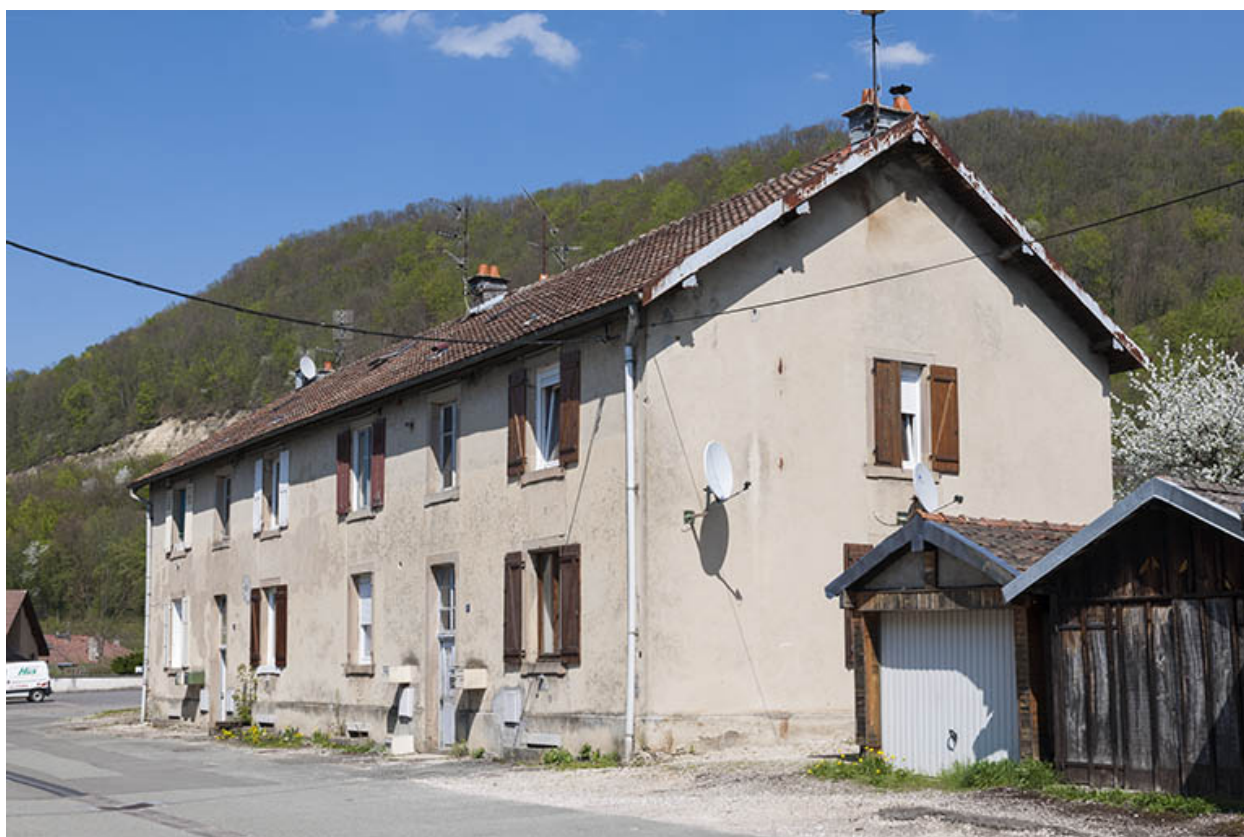
Habitation (6-8 logements) vue de trois quarts.
