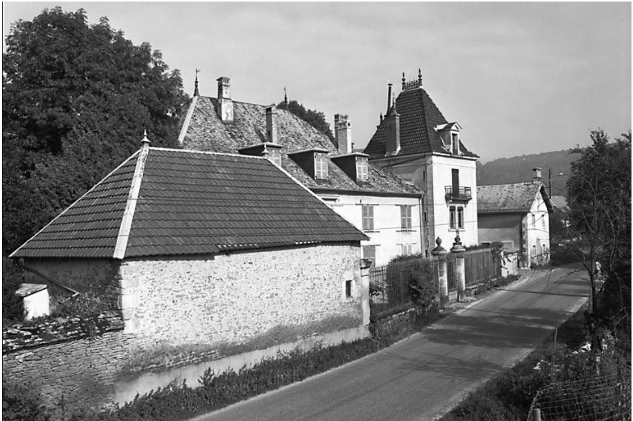
Demeure située rue du Général Broissia.
