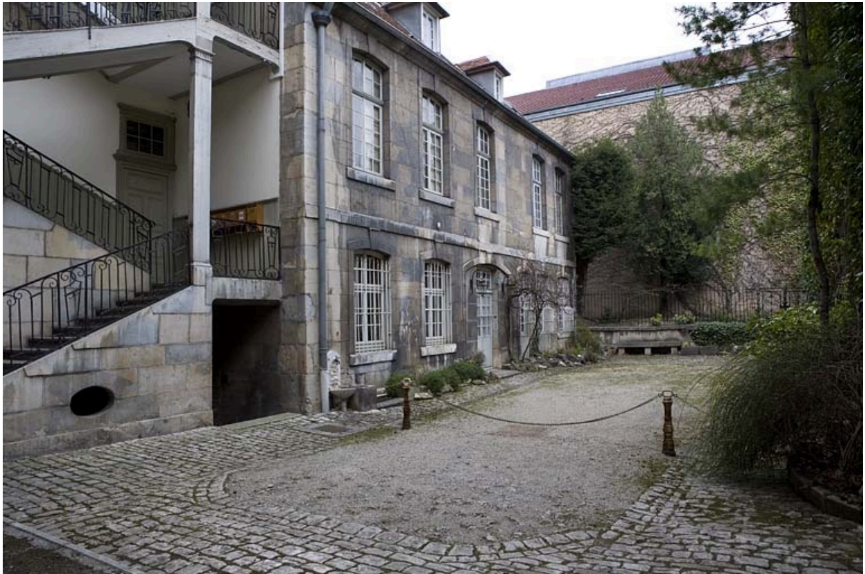
Vue d'ensemble de l'aile gauche sur cour.
