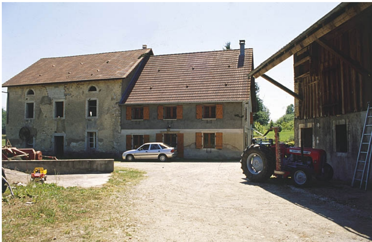
Façade antérieure du moulin et du logement.
