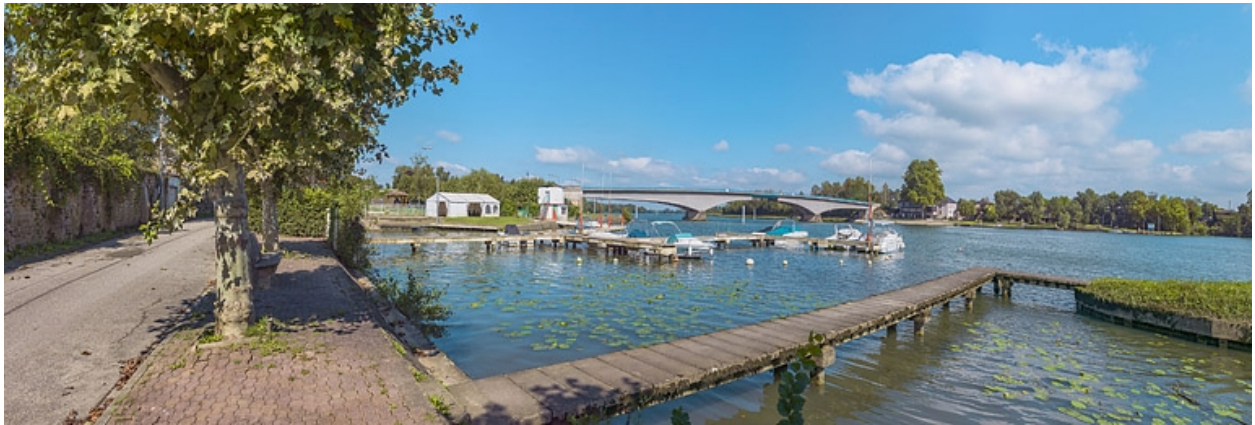
Le port et le pont de Saint-Romain, vus depuis la rive droite.
