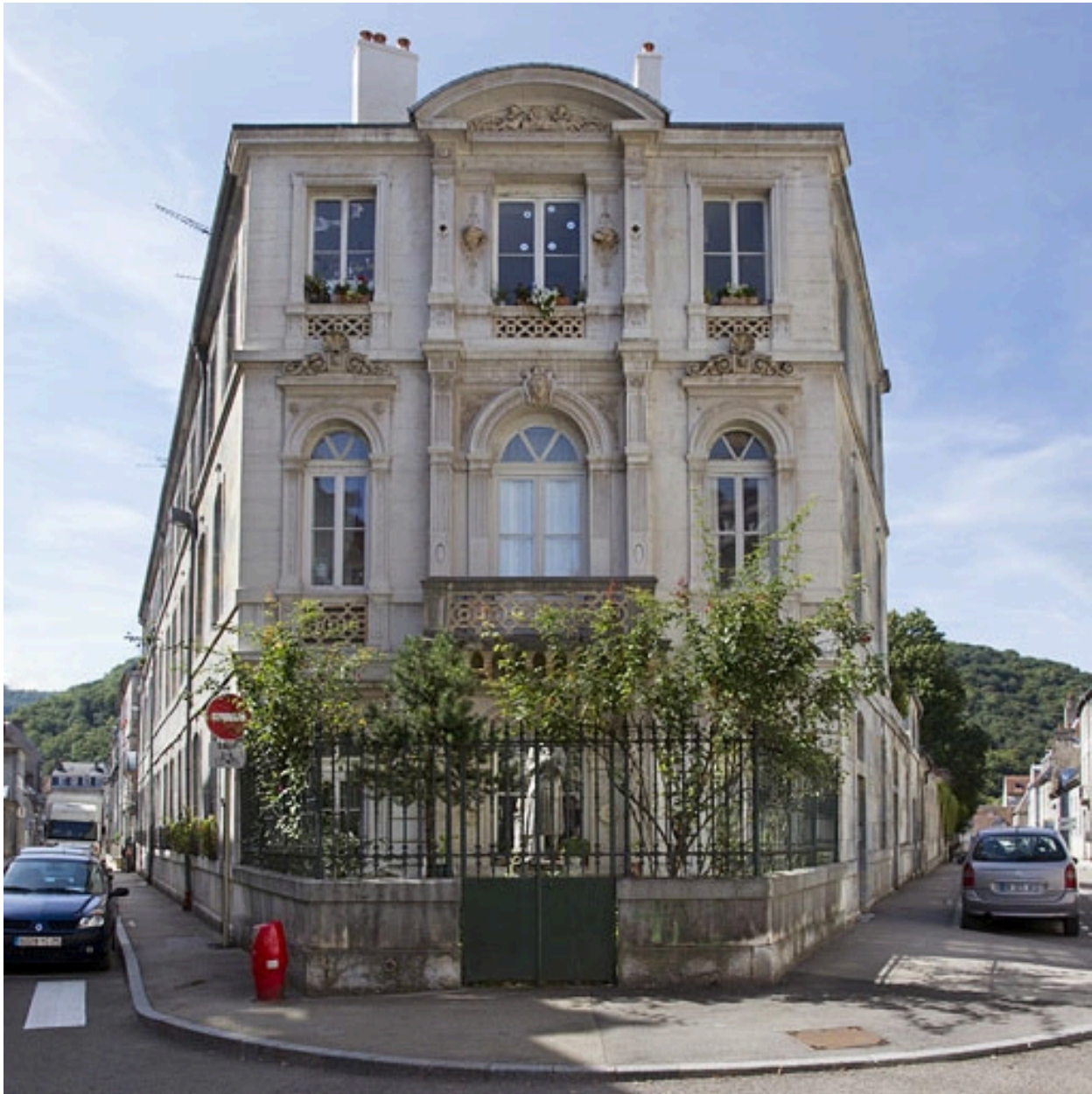
Façade d'angle : de face.
