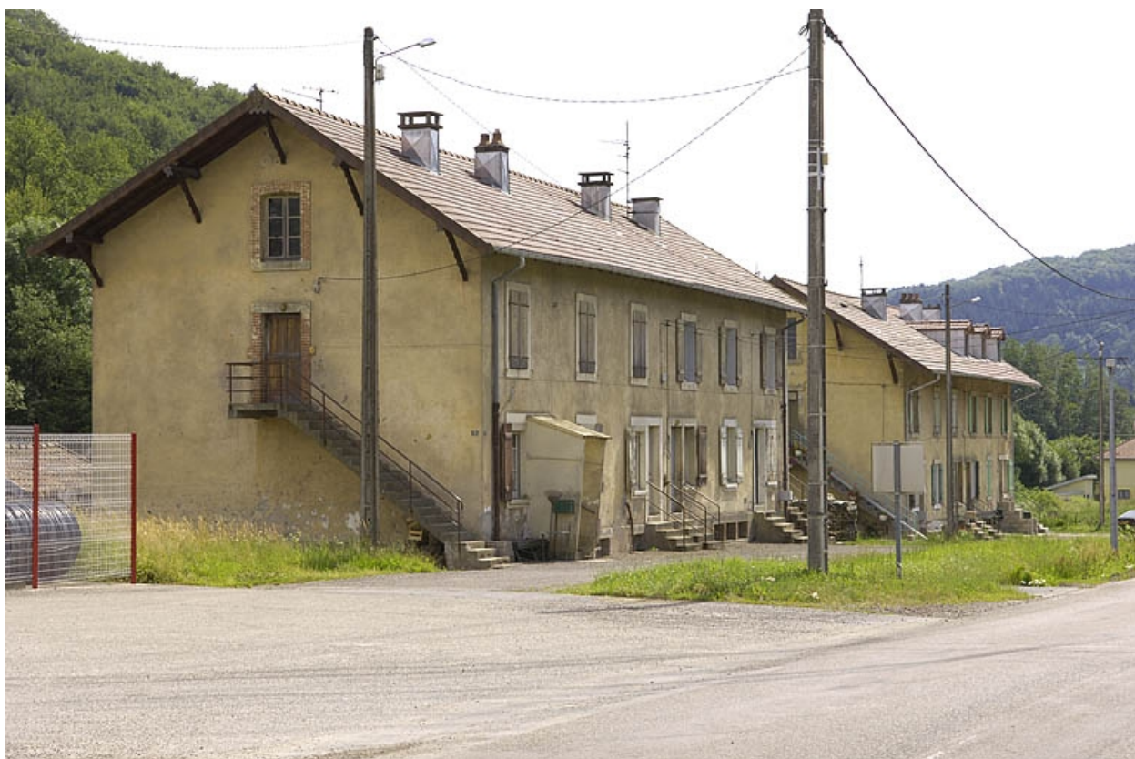
Vue d'ensemble des logements ouvriers.
