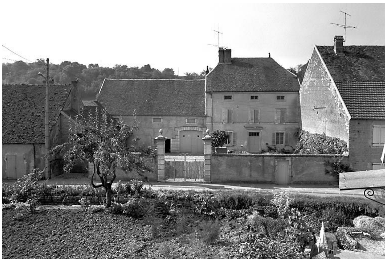
Ferme située 34 rue du Canal.
