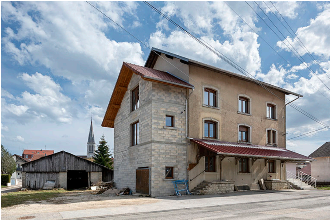
Façades antérieure et latérale gauche.
