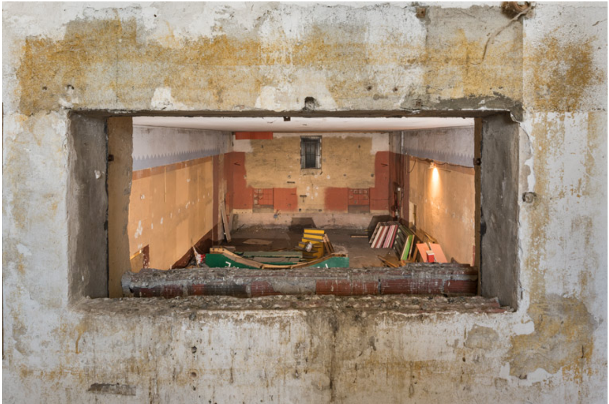
Salle, vue de la cabine du projectionniste.
