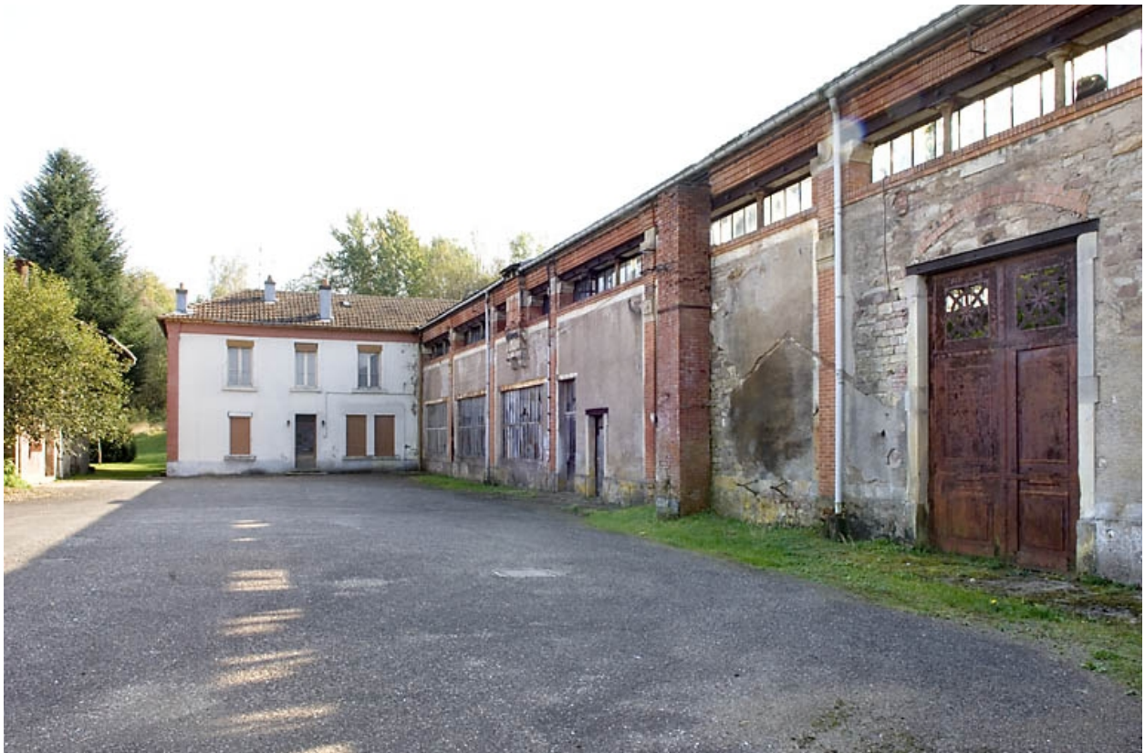
Vue d'ensemble depuis l'entrée.
