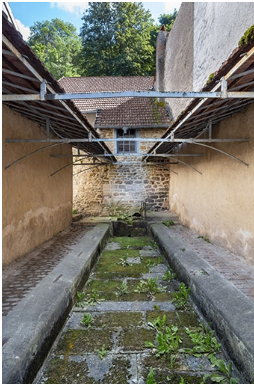
L'intérieur de la fontaine-lavoir.
