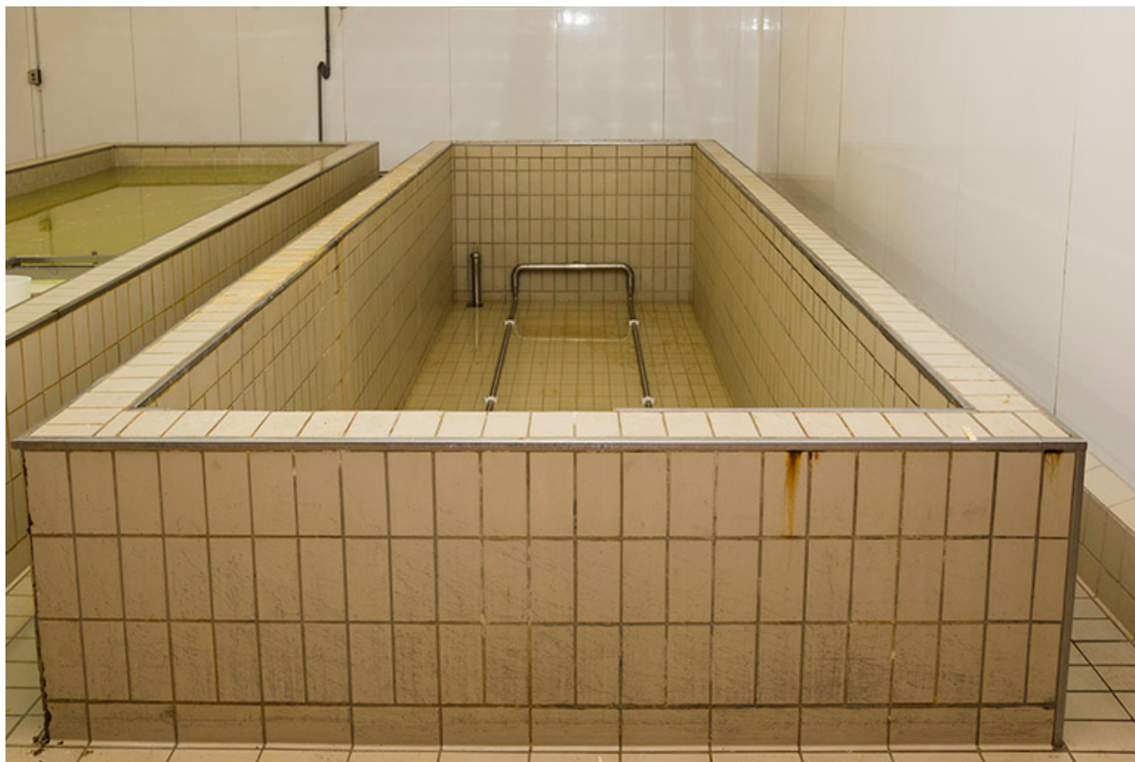
L'une des deux cuves à saumure.
