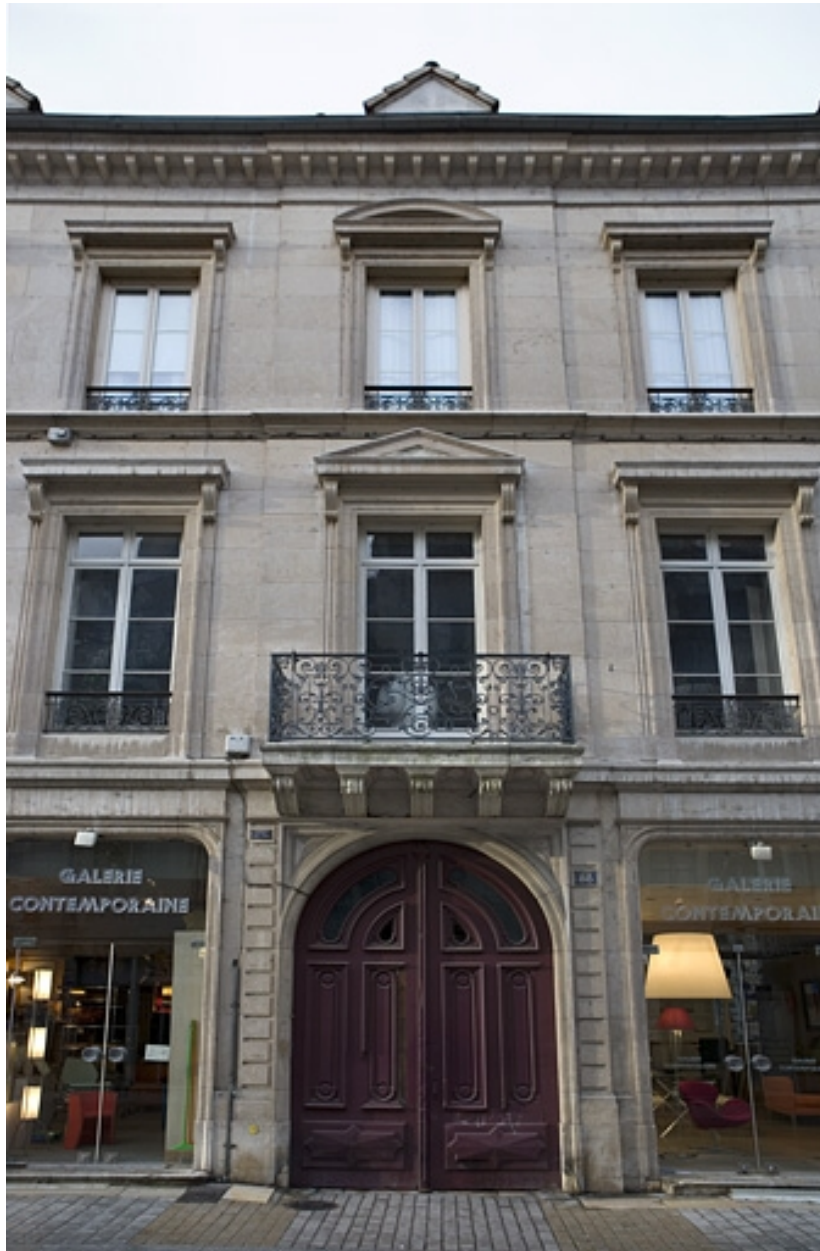
Vue rapprochée de la façade sur rue, de face.
