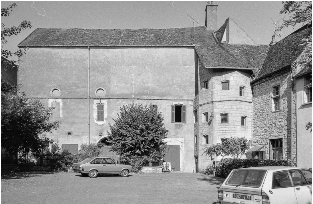
Façade sur cour.
