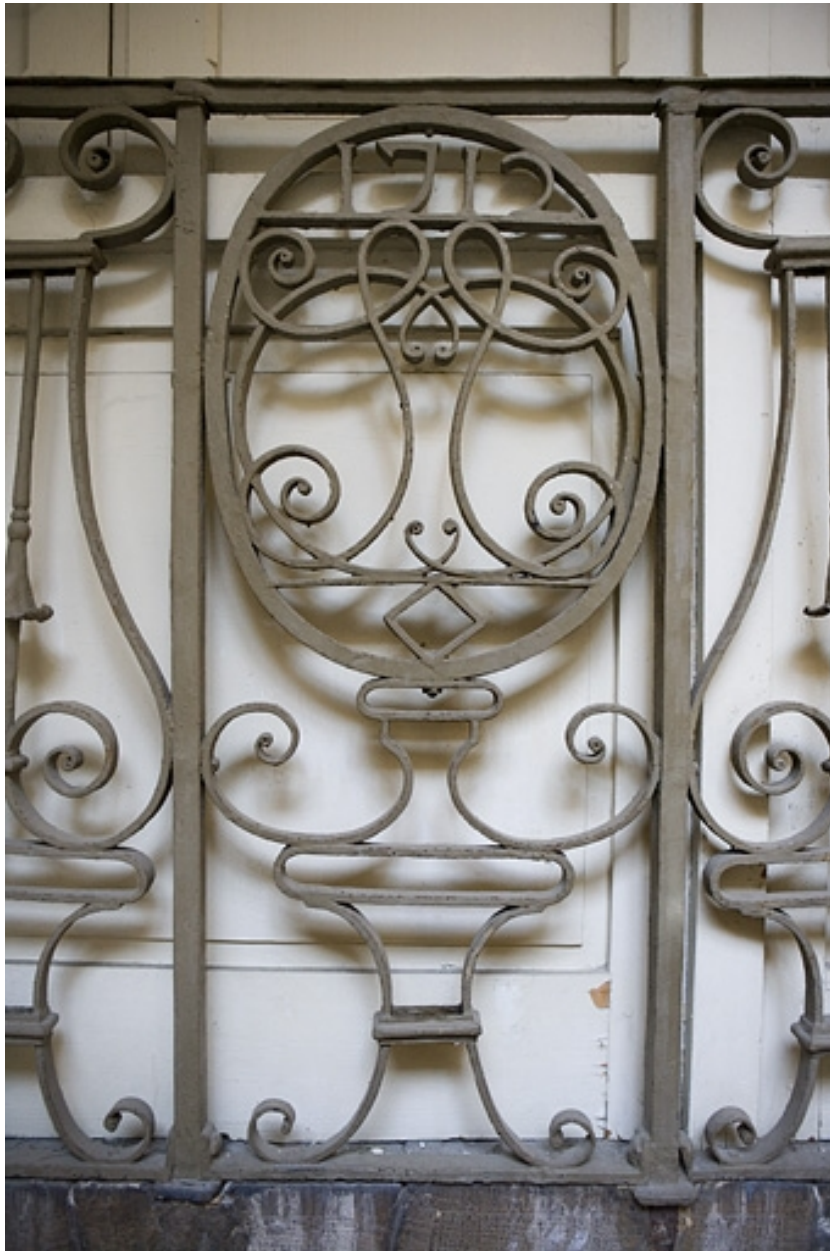
Détail de la ferronnerie de l'escalier à cage ouverte.
