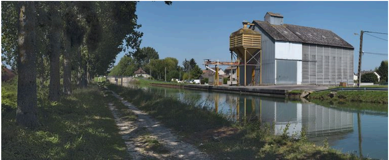
Silo avec système de déchargement lié au canal à Longecourt-en-Plaine.
