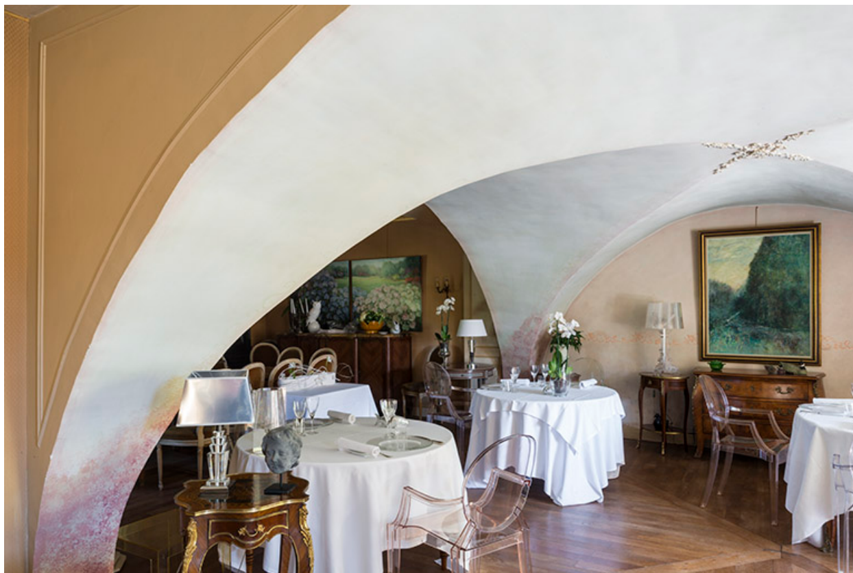
Détail d'une des voûtes.
