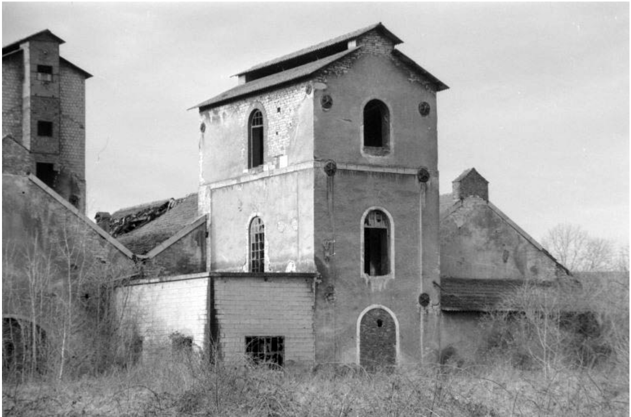
Monte-charge des hauts-fourneaux au bois (D), vu de l'est.
