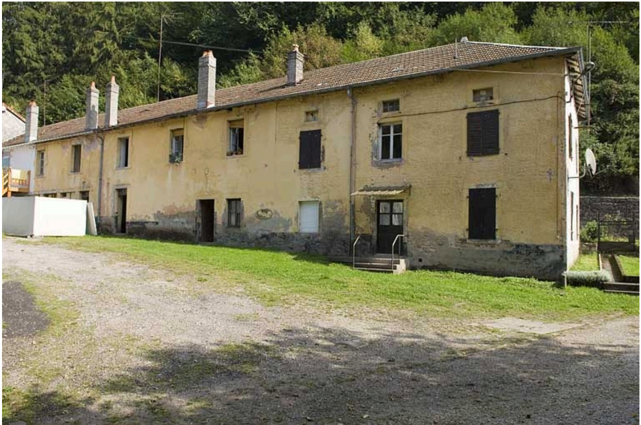
Façade occidentale des logements ouvriers.
